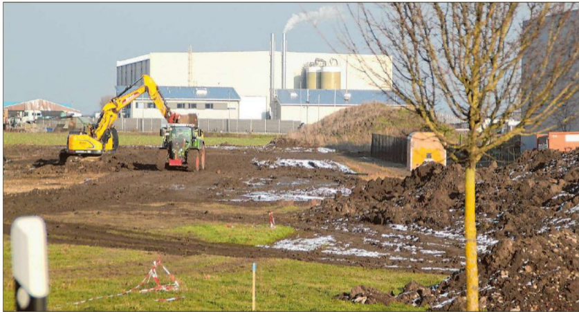
Derzeit wird bereits der Humus auf dem Gelände in Burgbernheim abgetragen. Foto: Hans-Bernd Glanz
